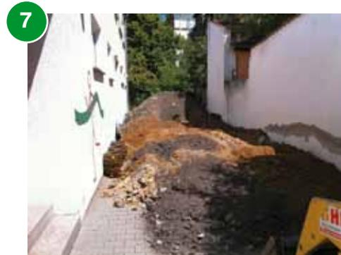
Unser Sorgenkind - belasteter Bodenaushub, den wir speziell entsorgen mussten
