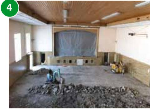
Die Betondecke wird abgetragen
