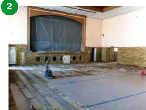
Der alte PVC Belag wird entfernt
