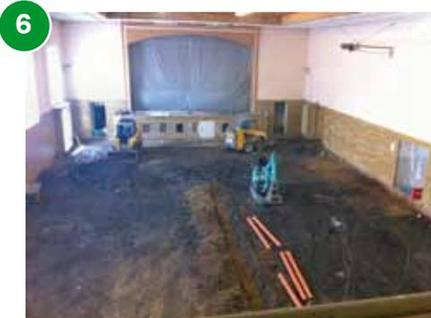
Leerrohre zur Versorgung des Bühnenkellers werden gelegt
