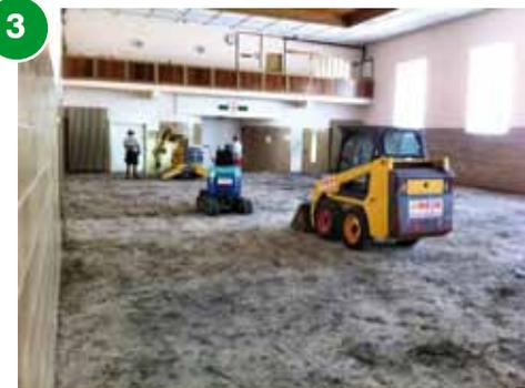
Die oberste Bitumenbeschichtung wird entfernt
